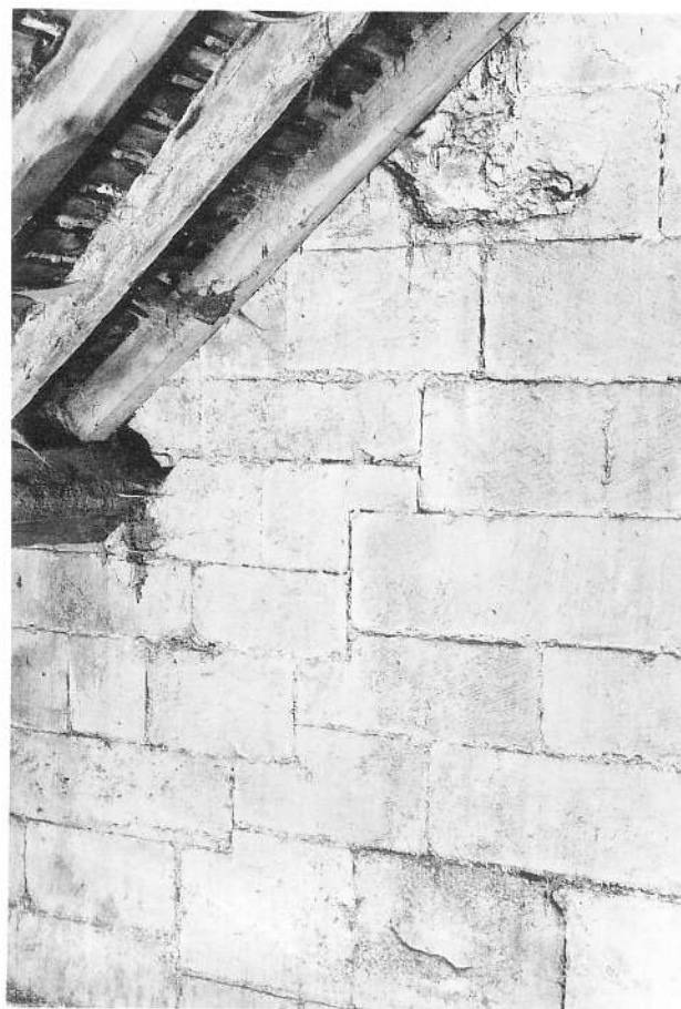
28. Collage de maçonneries du XII e siècle sur le côté ouest de la tour d'escalier nord, vu depuis les combles de la chapelle Sainte-Geneviève.
