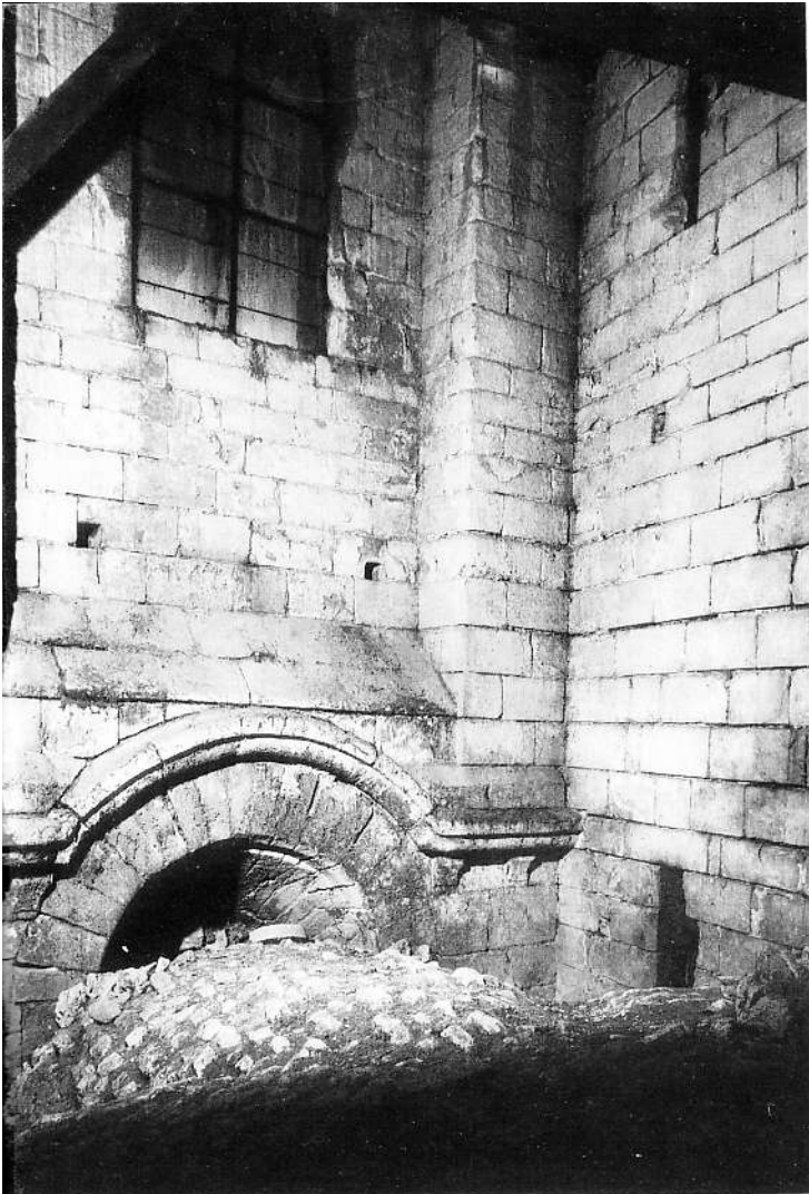
29. Extérieur du mur nord de la travée droite du chœur, vu depuis les combles de la chapelle Saint-Gervais-Saint-Protais (ou du Sacré-Cœur). À droite, mur oriental de la tour d'escalier nord.
