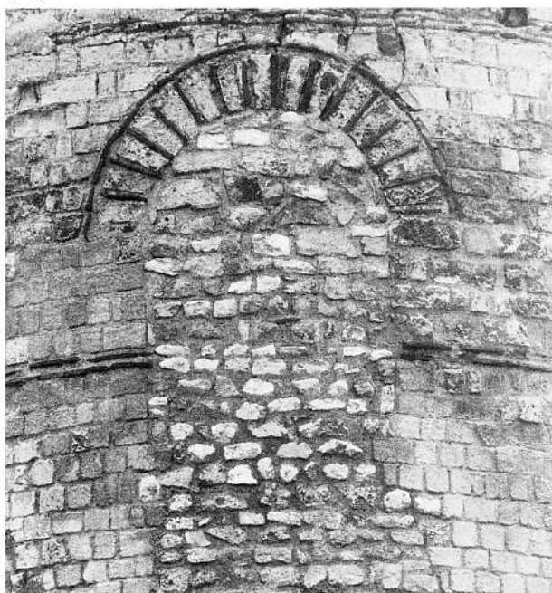
51a. Tour de l'enceinte gallo-romaine, annexée à l'ancien palais royal.
