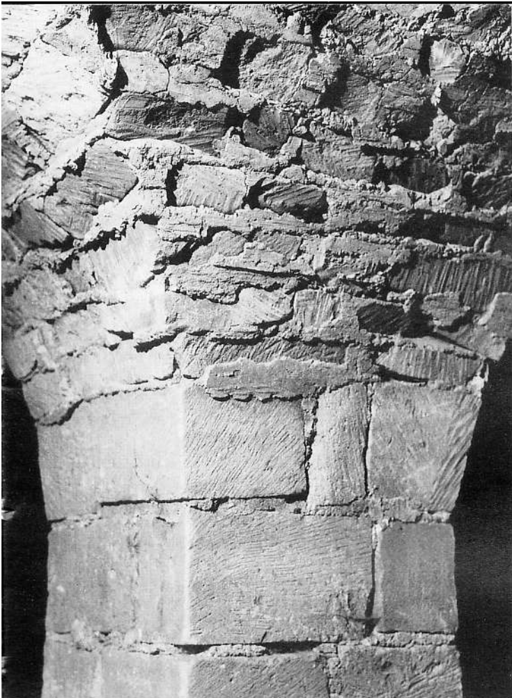
9. Pilier et retombée de la voûte de la chapelle octogonale.
