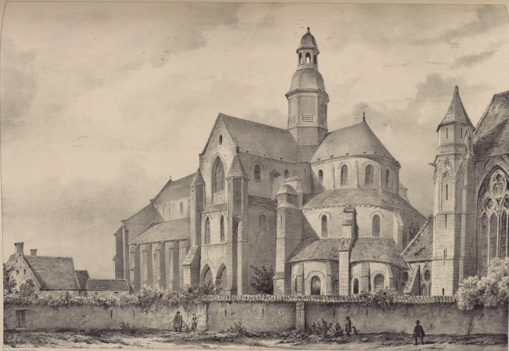
Vue générale de l'Eglise de St Germer Rouen
