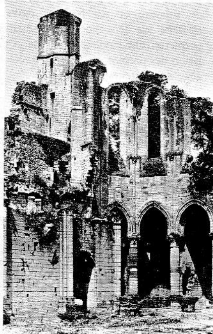
Ruines de la chapelle, côté nord
