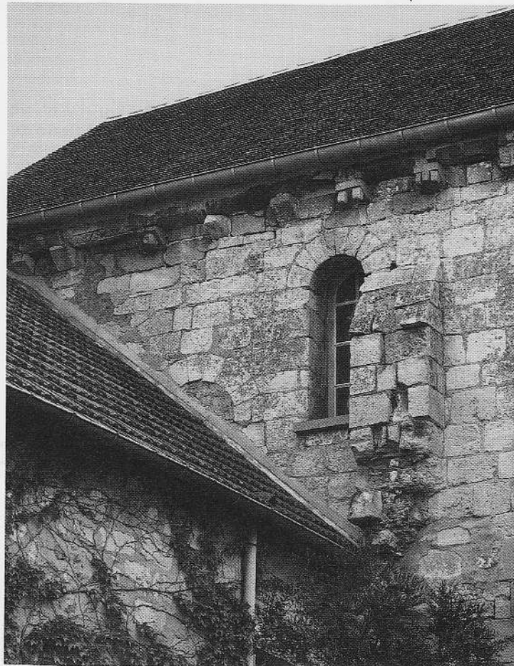
5. Extrémité orientale du mur nord de la nef montrant l'archivolte de la porte haute, à gauche de la fenêtre (photo D. Vermand).
