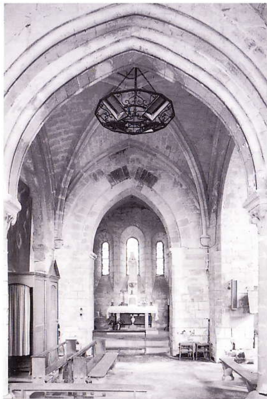
4 (ci-contre) - La croisée du transept, vue vers le nord. Au premier plan, l'arcade refaite à la fin du 12 ème siècle; au second plan, l'arcade d'entrée du croisillon nord, renforcée à une date indéterminée. La voûte de la croisée est du 14 ème siècle (photo D. Vermand).
