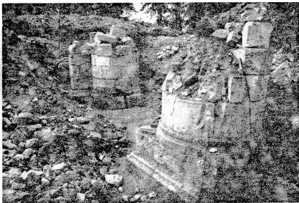
33. Piles du déambulatoire du bras Nord en 1961
