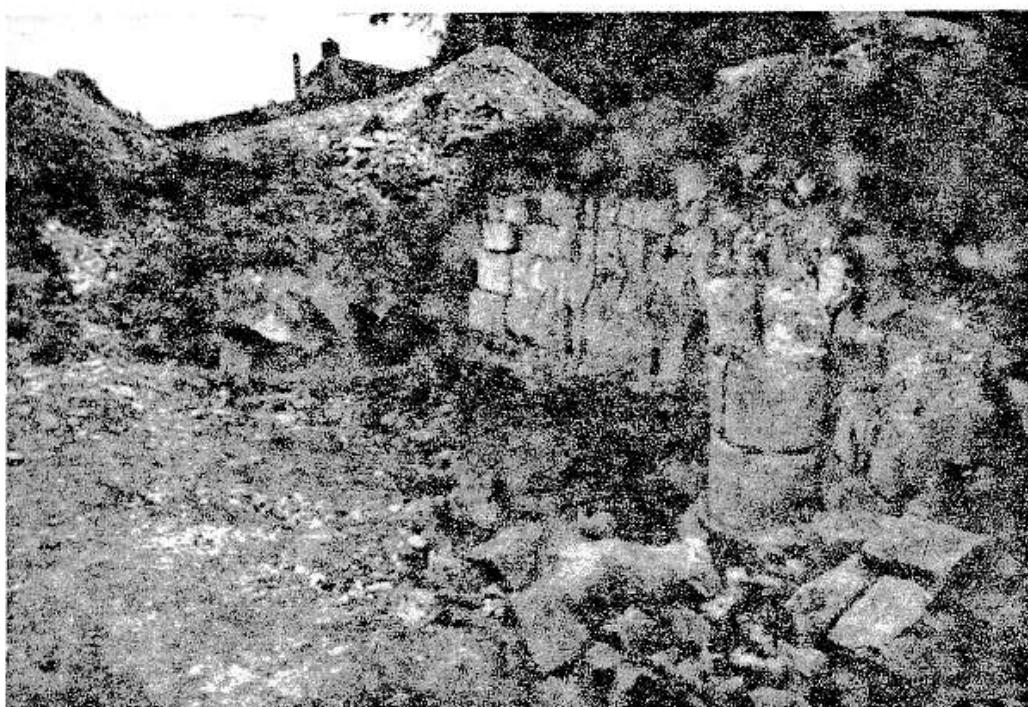
32. Mur du déambulatoire du bras Nord en 1961
