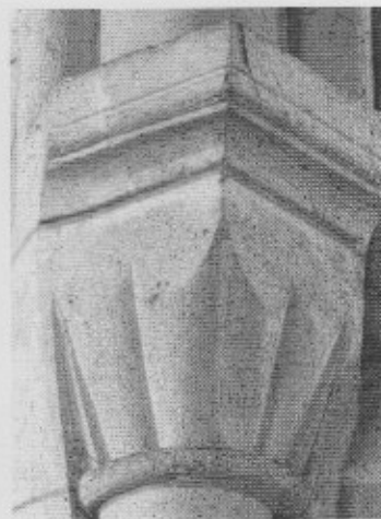
328 (ci-contre, à gauche). Acy-en-Multien. Chapiteau à godrons à la retombée nord-ouest de la voûte du clocher.
